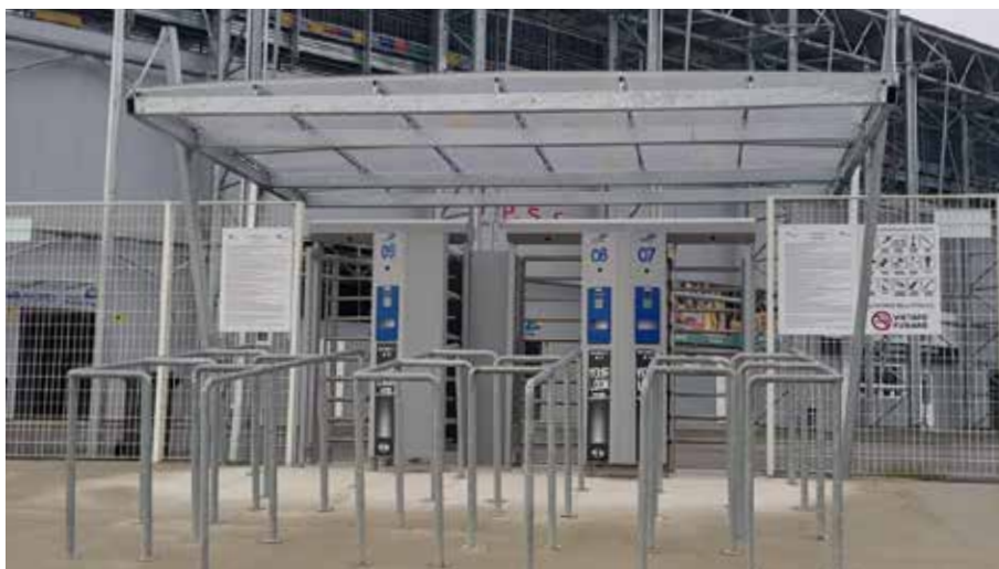
La copertura realizzata per tutti i tornelli dell'impianto
